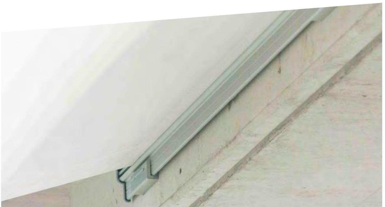
Wandanbindungsschiene, montiert mit den dazugehörigen Konsolen
